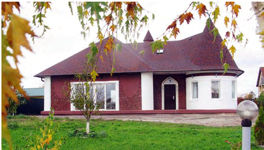
Рис. 1.1. Жилой дом, напечатанный на 3D-принтере
