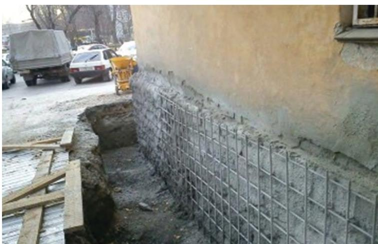
Рис. 1.8. Ремонт фундамента МКД
