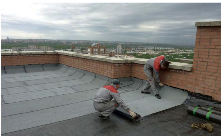
Рис. 1.5. Ремонт кровли МКД
