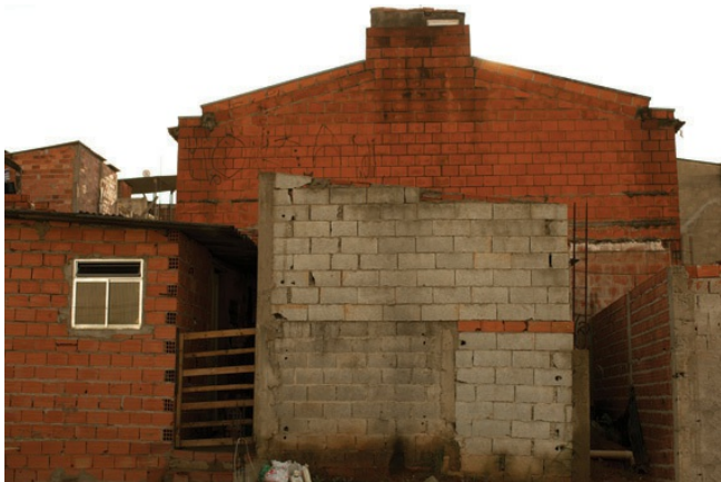
Вид со двора на «самострой» mutirão
