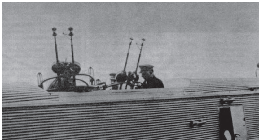
Открытая турельная спаренная пулеметная установка в фюзеляже ТБ-3.
