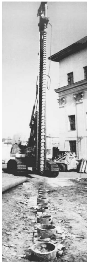
Рис. 2.2. Ограждение котлована из труб с обвязочным поясом
