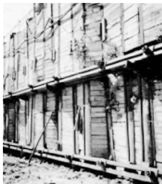
Рис. 2.13. Два яруса анкерных креплений ограждения из труб с деревянными забирками
