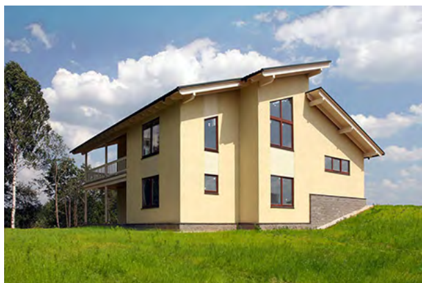
Рис. 1.7. Пример жилого малоэтажного дома на основе каркасной конструктивной системы с ограждающими конструкциями из OSB. Фасад под покраску
