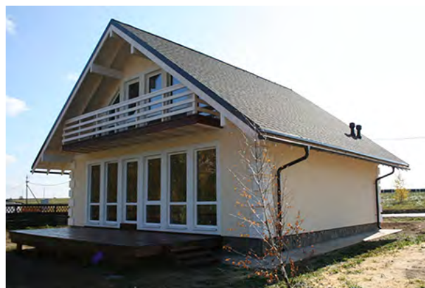
Рис. 1.8. Малоэтажный жилой дом с внешней отделкой штукатурным слоем
