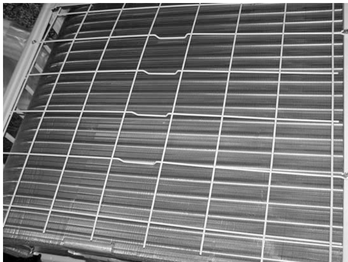
Рис. 1.3. Вид на конденсатор-радиатор наружного блока
