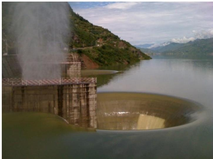
Рис. 1.4. Водослив автоматического действия шахтного водосбора действующего гидроузла Тери (Индия)
