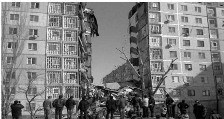
Рис. В1. Момент лавинообразного обрушения секции 9-этажного крупнопанельного жилого дома в Астрахани
