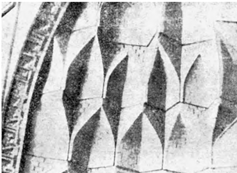
Рис. 1.4. Мечеть Пятницы (Исфаган, Иран). Деталь мелкоячейистой арочной структуры одного из кирпичных айванов
