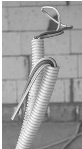
Рис. 12. Проводка в ПВХ-трубах
