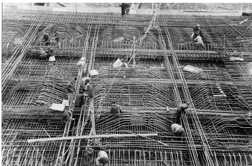
Рис. 7. Устройство коробчатой фундаментной плиты здания МГУ
