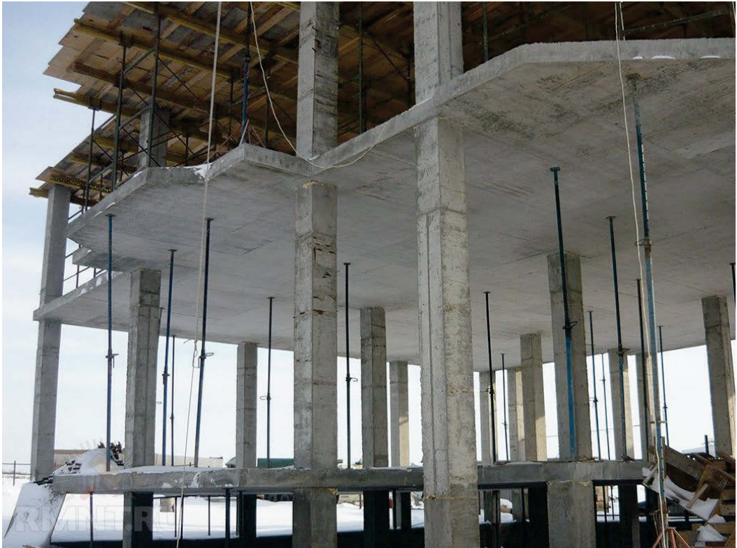
Рис. 1.1. Гладкие монолитные железобетонные перекрытия
