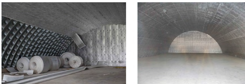
Рис. 1.6. Формирование изоляционной оболочки
