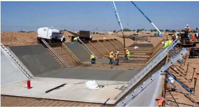
Рис. 1.6. Устройство бетонных облицовок при помощи:
