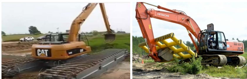
а Рис. 1.2. Работа экскаватора: б
