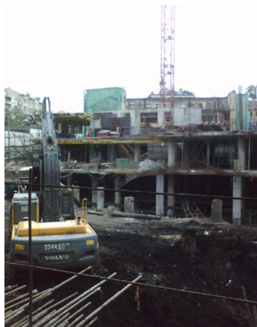
Рис. 2.4. Строительство методом semi-top-down объекта «Неглинная-плаза» по адресу: Москва, ул. Рождественка, 29
