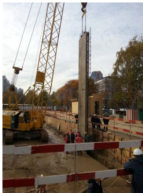
Рис. 2.1. Устройство сборной «стены в грунте» для подземной автостоянки на объекте «ЖК МИД» по адресу: Москва, Ленинский пр., 97
