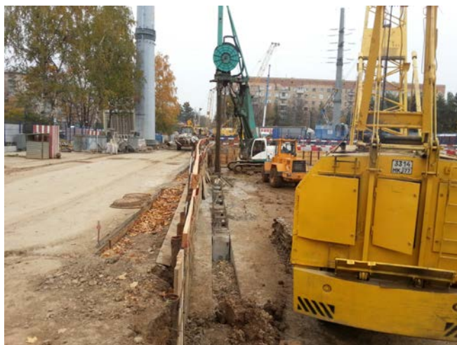
Рис. 2.2. Устройство траншеи для «стены в грунте» для подземной автостоянки на объекте «ЖК МИД» по адресу: Москва, Ленинский пр., 97
