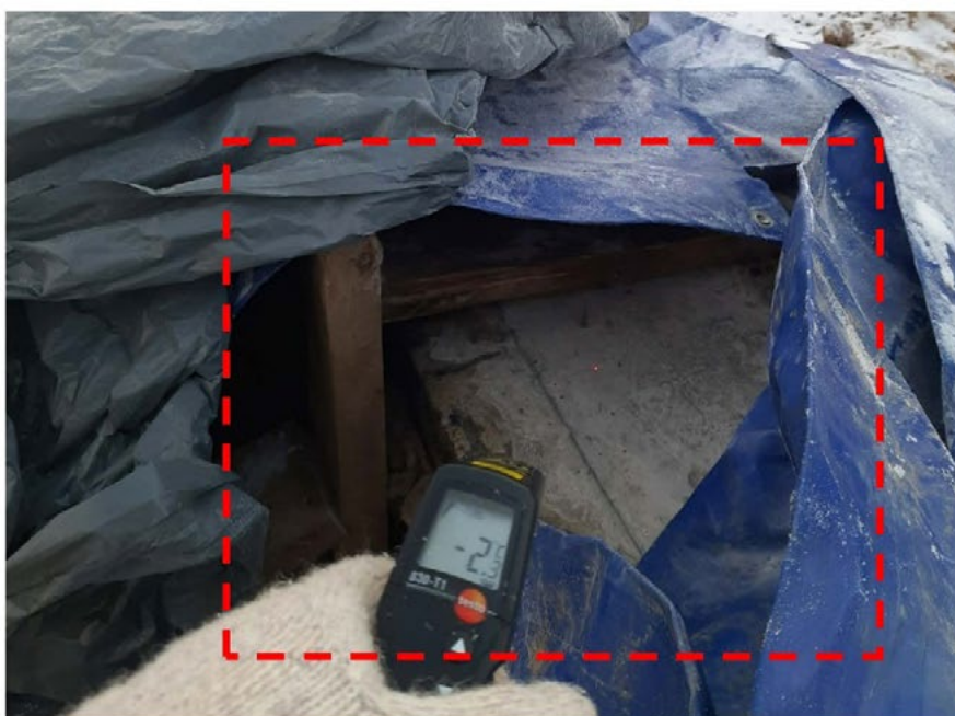
Рис. 2.3. Предписание строительного контроля технического заказчика
