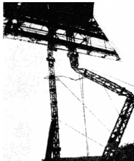
Рис. 1.5. Авария при строительстве высоковольтной линии электропередач
