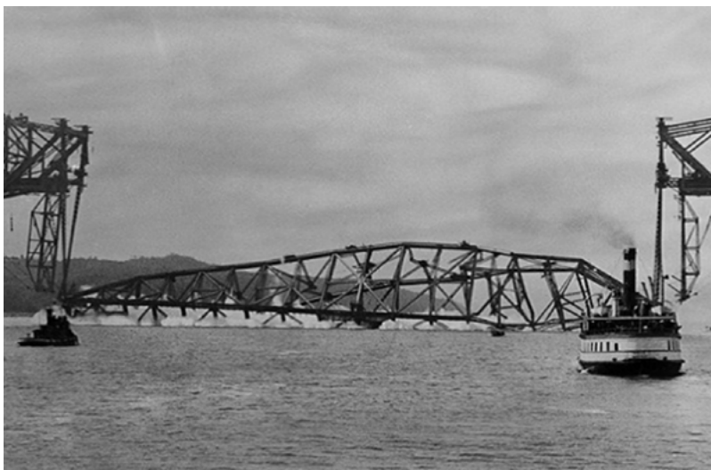
Рис. 1.4. Вторая авария при сооружении моста в г. Квебек, Канада
