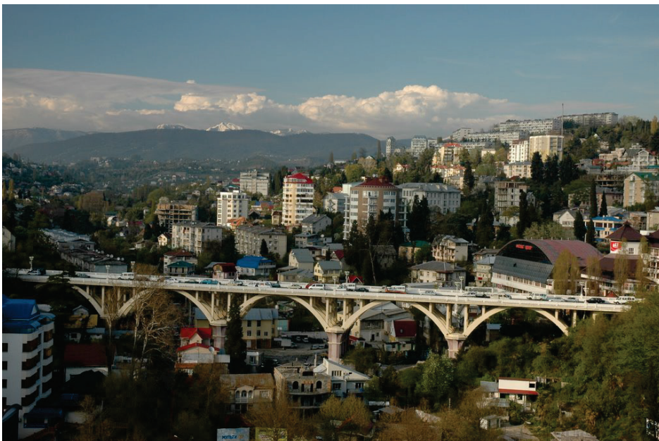
Архитектор Н. Б. Соколов и инженер Ю. О. Львов. Верецагинский виадук. 1934–1935 г. Сочи. СССР. Автодорожный мост над долиной реки Верецагинки, соединяющий Центральный и Хостинский районы города. Сегодня он известен как Светлановский мост
