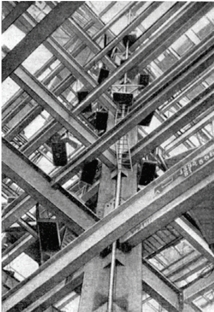
Металлоконструкция центральной части главного корпуса МГУ. Прямые балки к несущей колонне. 1950 г.
