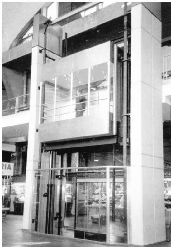
Рис. 1.9. Общий вид кабины панорамного гидравлического лифта
