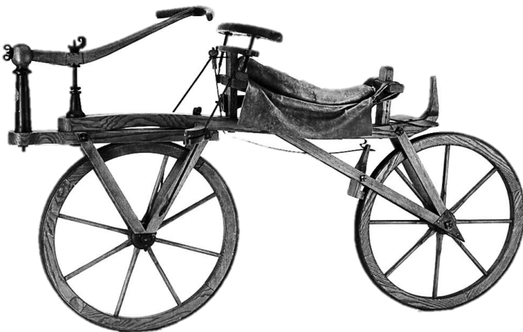
Рис. 2.1 Машина для бега — дрезина
