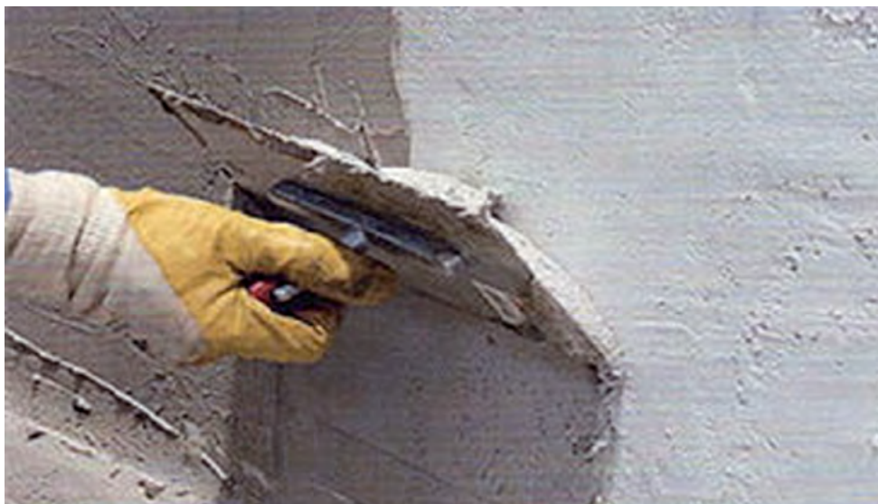
Рис. 5. Штукатурная гидроизоляция
