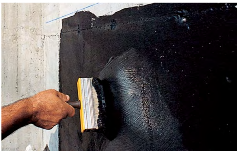
Рис. 3. Процесс нанесения гидроизоляции на подготовленную гидроизолируемую поверхность
