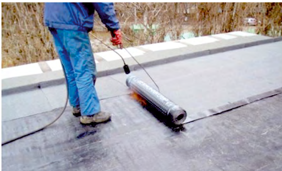
Рис. 4. Рабочий процесс по устройству оклеечной гидроизоляции
