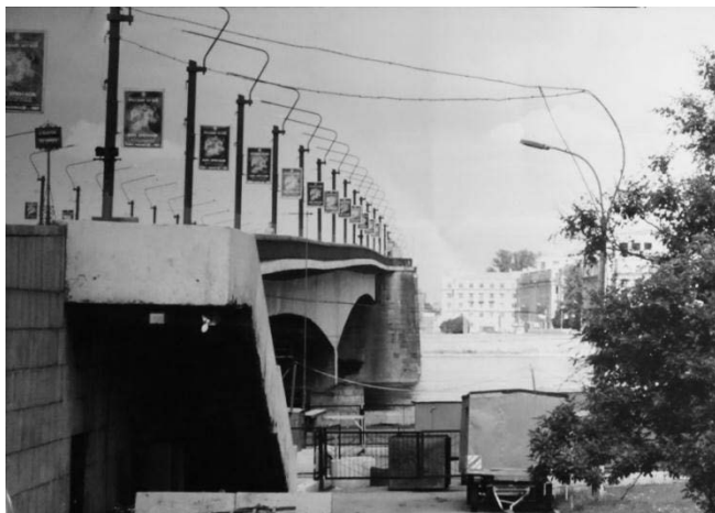
Мост им. Александра Невского в Санкт-Петербурге. Сооружен в 1964 г. Преднапряженный железобетон. Снимок 1998 г.
