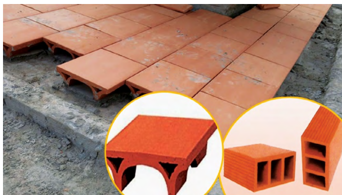
Рис. 1.1. Теплоизоляция для кровли с использованием полого кирпича
