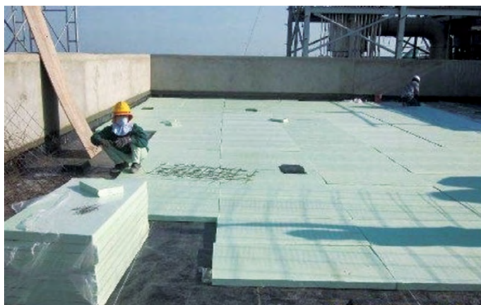
Рис. 1.2. Теплоизоляция для кровли с использованием пены
