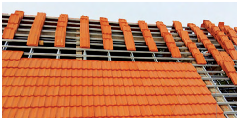
Рис. 1.3. Решения теплоизоляционной крыши с использованием кровельной черепицы
