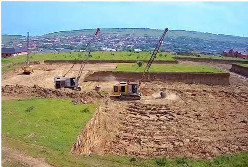
Рис. 10. Уплотнение трамбовками строительного котлована в лессовых грунтах
