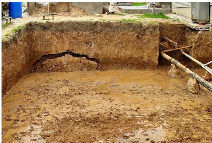
Рис. 11. Вид котлована после предварительного замачивания просадочных лессовых грунтов
