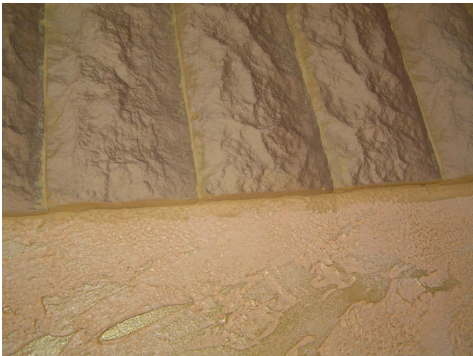
Рис. 1.9. Облицовка искусственным камнем уголка и стыков стен
