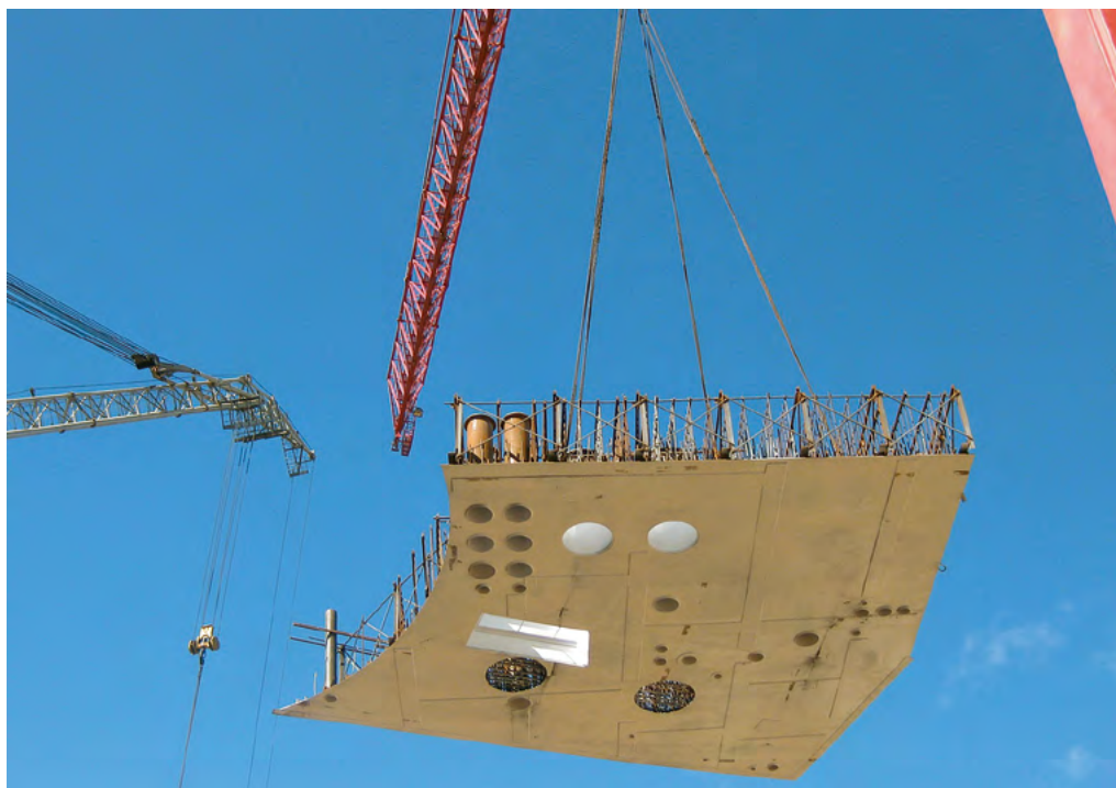
Рис. 1.3. Монтажный блок перекрытия с установленными проходками и листом несъемной облицовки-опалубки (Калининская АЭС, энергоблок № 4 (АЭС с ВВЭР-1000, унифицированный проект))
