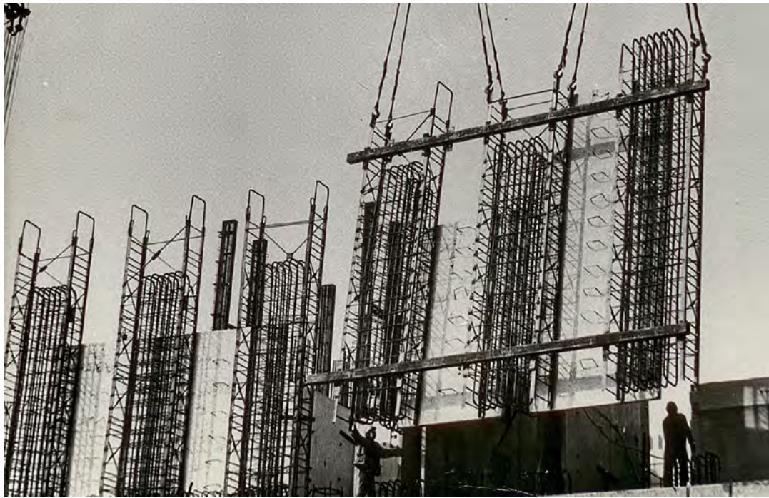
Рис. 1.7. Укрупненный стеновой блок на монтаже с армокаркасами. Пример (Запорожская АЭС)
