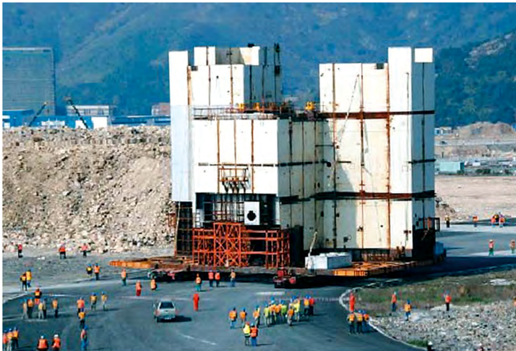
Рис. 1.4. Единый монтажный фрагмент несъемной опалубки, состоящий из отдельных элементов стен и перекрытий. Проект АЭС AP1000 («Вестингауз», США)
