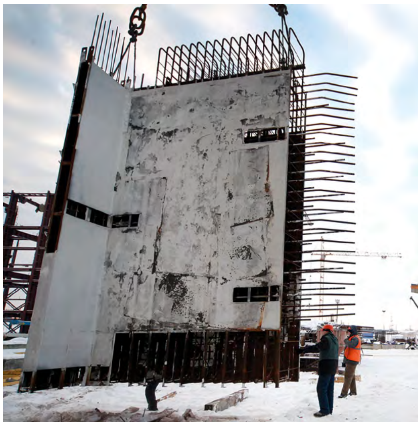
Рис. 1.2. Армоопалубочный блок в процессе монтажа (Нововоронежская АЭС-2)
