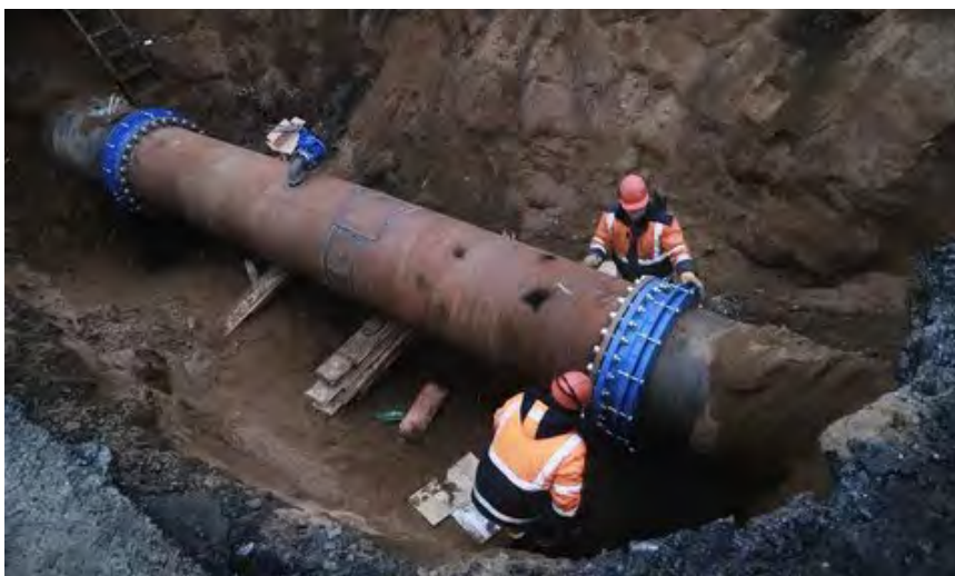
Рис. 4. Замена участка стального трубопровода
