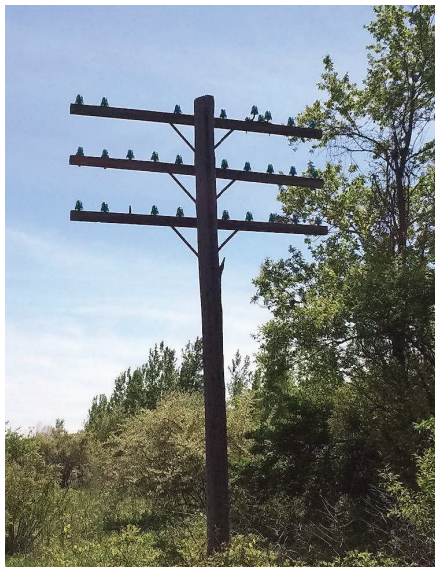
Рис. 1.2. Столбы междугородной телефонной сети
