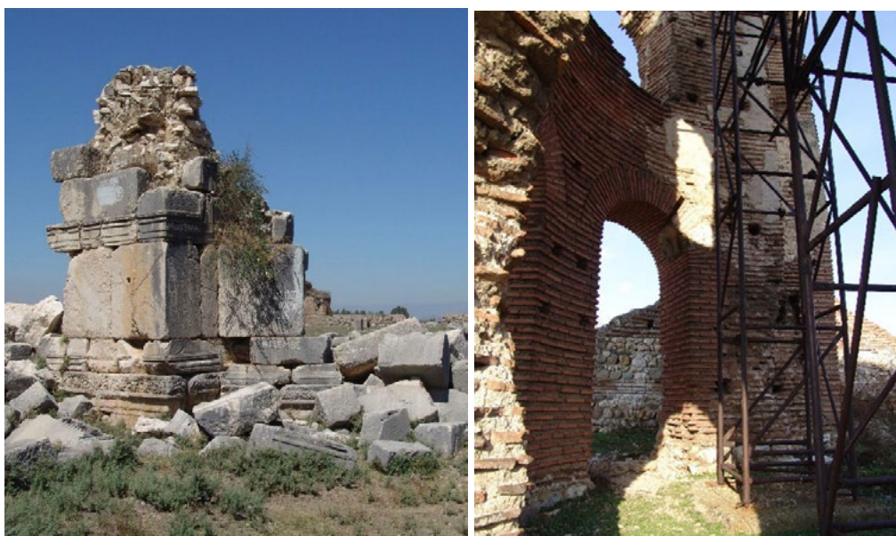
Рис. 2. Кладка стен ранневизантийских храмов: а — каменная с бутобетоном в Аназарбе в Киликии; б — кирпичная в Красной церкви у Перуштицы во Фракии (фото А. Казаряна, 2005 и 2012)
