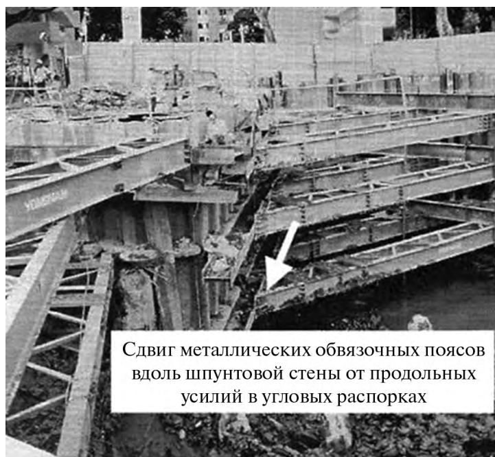
Рис. 2.2. Сдвиг обвязочных поясов вдоль шпунта более чем на 600 мм [6]
